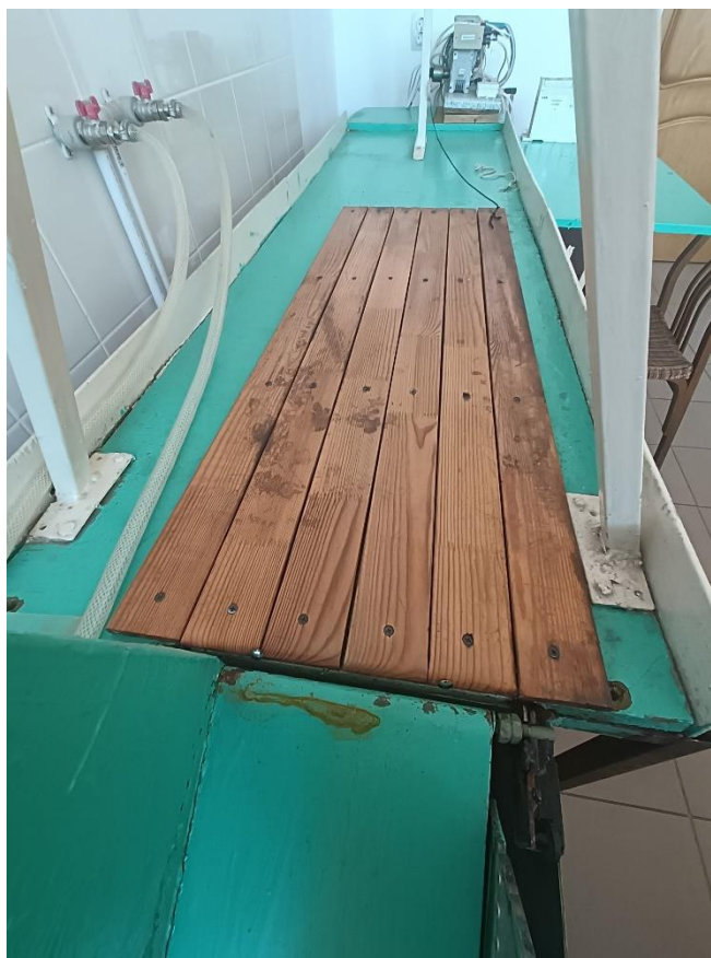
Рисунок 2.4 – Деревянный настил палубы
