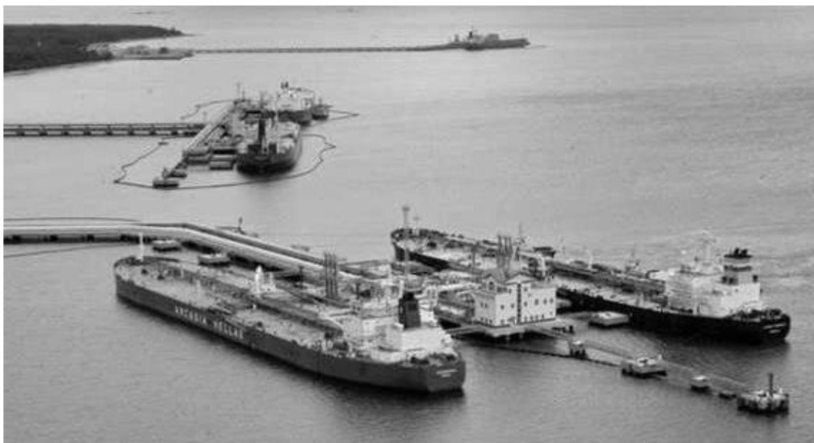
Рис. 8.7. Стационарный рейдовый причал
