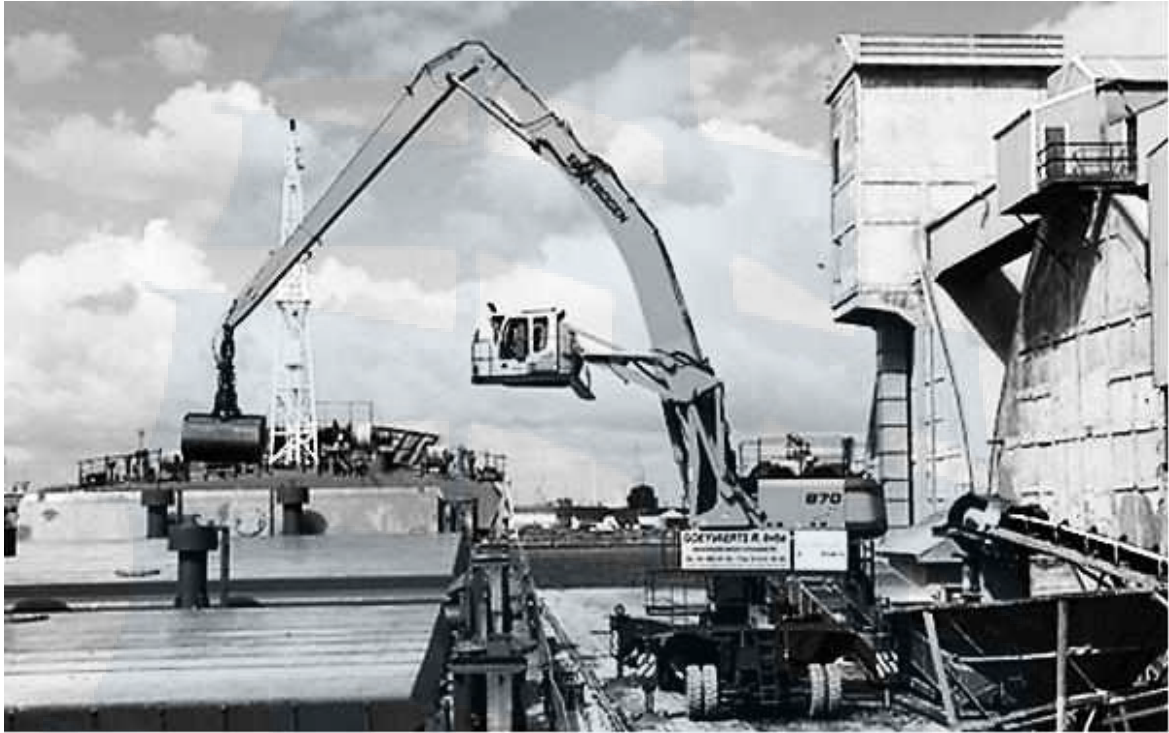
Рис. 149. Грейферно-конвейерный кран-перегрузатель
