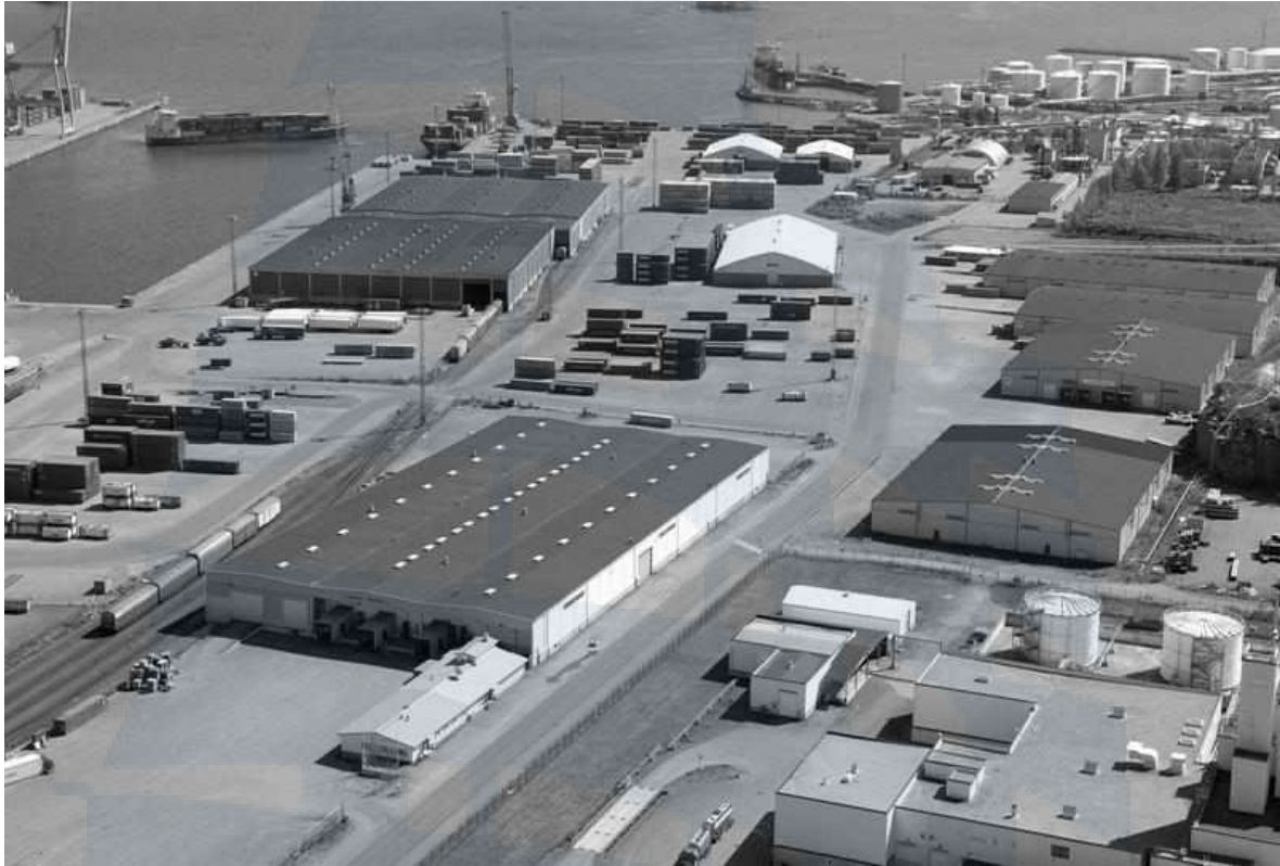
Рис. 118. Крытые одноэтажные склады в порту
