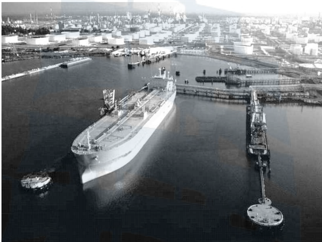
Рис. 94. Отстой судна на бочке (пале) кормой к гидротехническому сооружению
