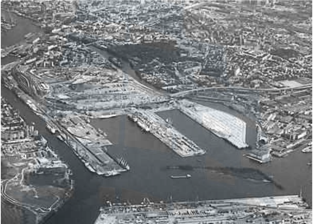
Рис. 88. Ковшовая форма причалов в порту Санкт-Петербург
