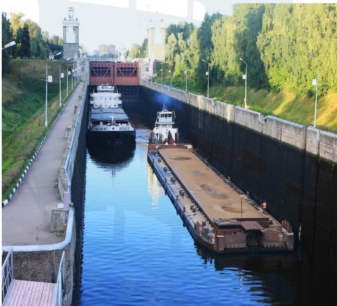
Рис. 95. Камера шлюза № 7 канала им. Москвы
