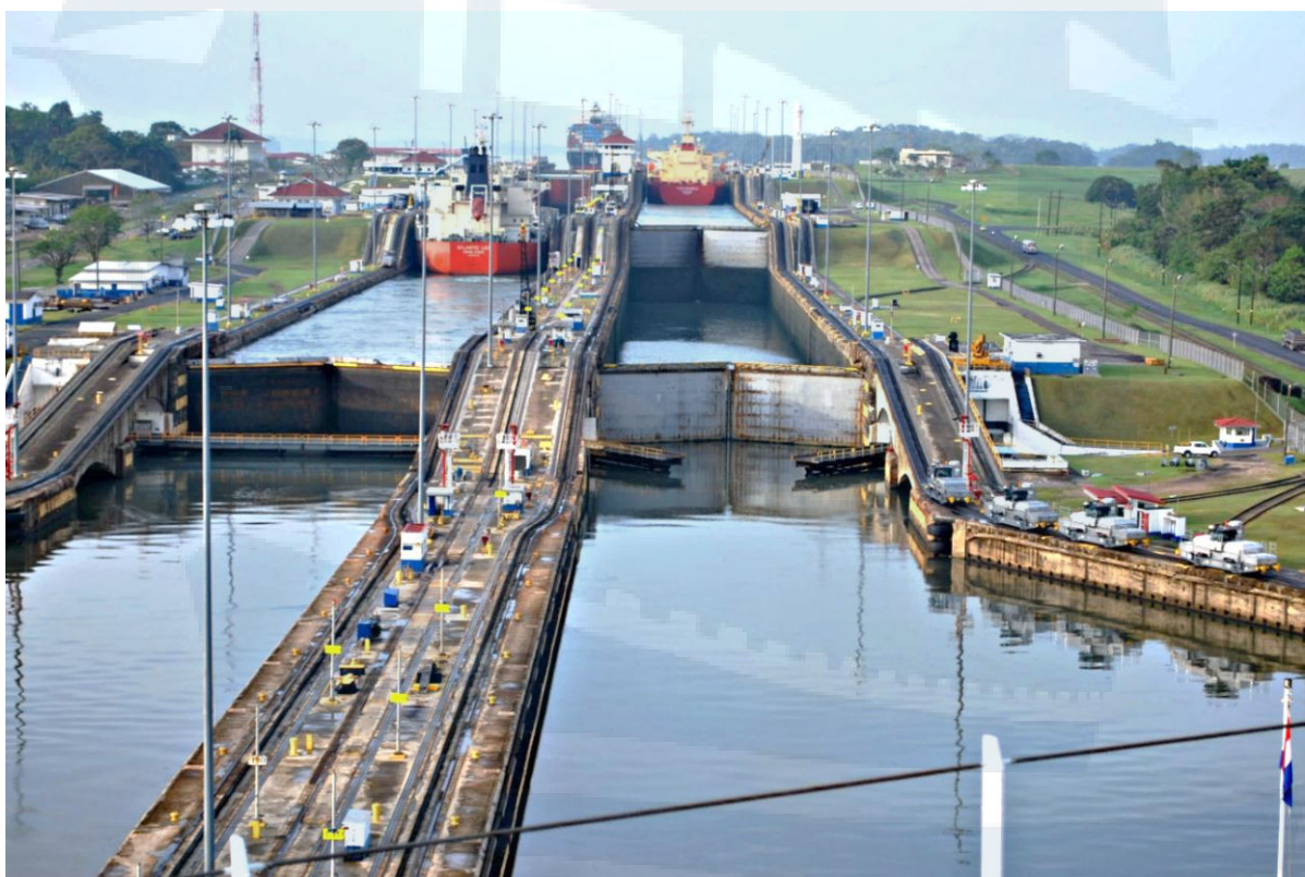
Рис. 93. Многокамерный двухниточный шлюз Панамского канала
