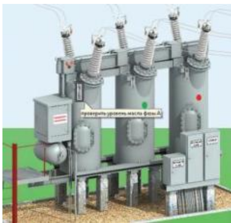
Рисунок 1.3 - Проверка текущего состояния
