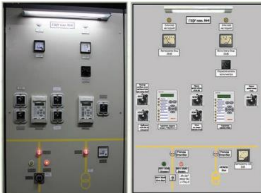
Рисунок 1.5 - Панель ГЦУ (слева-фото, справа – в тренажере)
