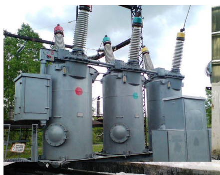
Рисунок 1.1 –Выключатель МКП-110М, разрез фазы (а), внешний вид (б).
