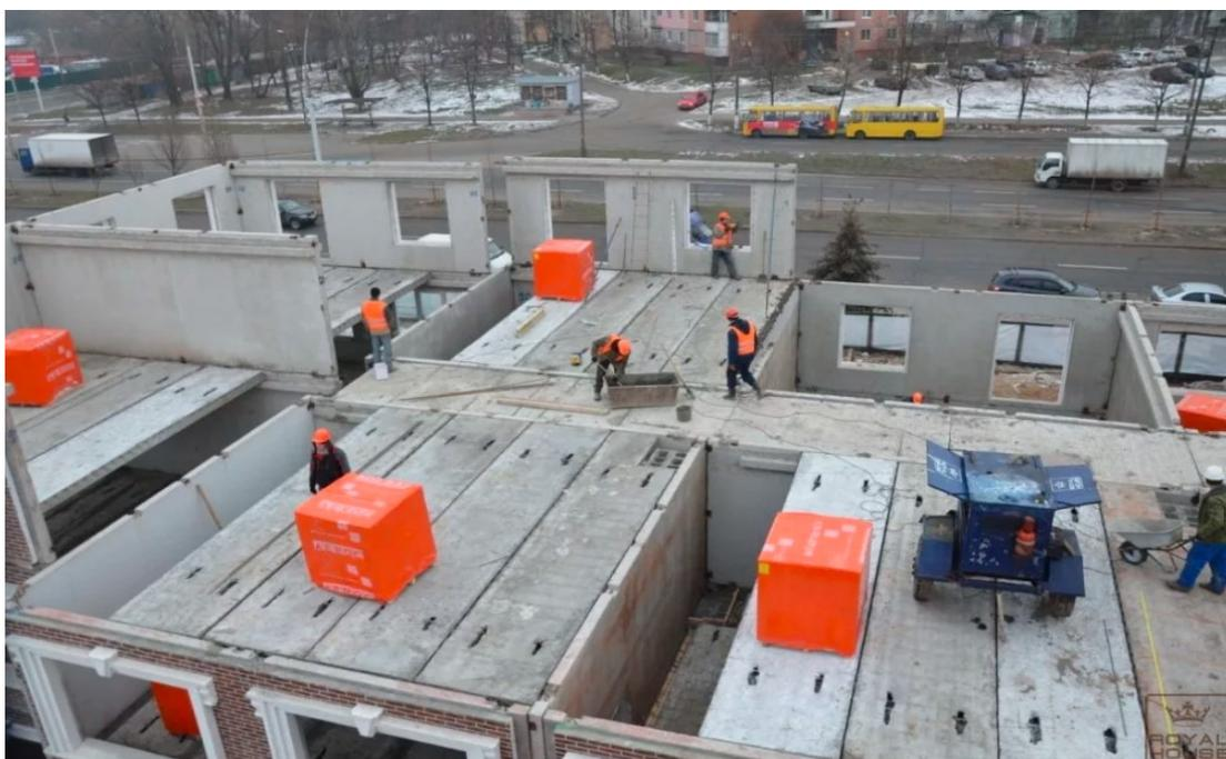
Рисунок 3.7 – Монтаж железобетонных конструкций при возведении многоэтажного здания
