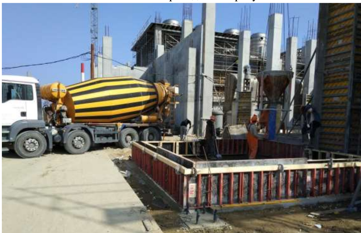
Рисунок 6 - Бетоновоз и подача бетона бадьёй.
