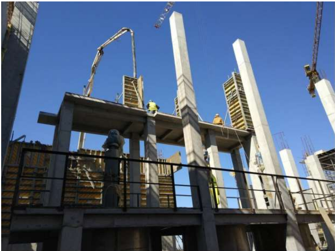
Рисунок 9 - Бетонирование колонн, подача бетонной смеси бетононасосом.
