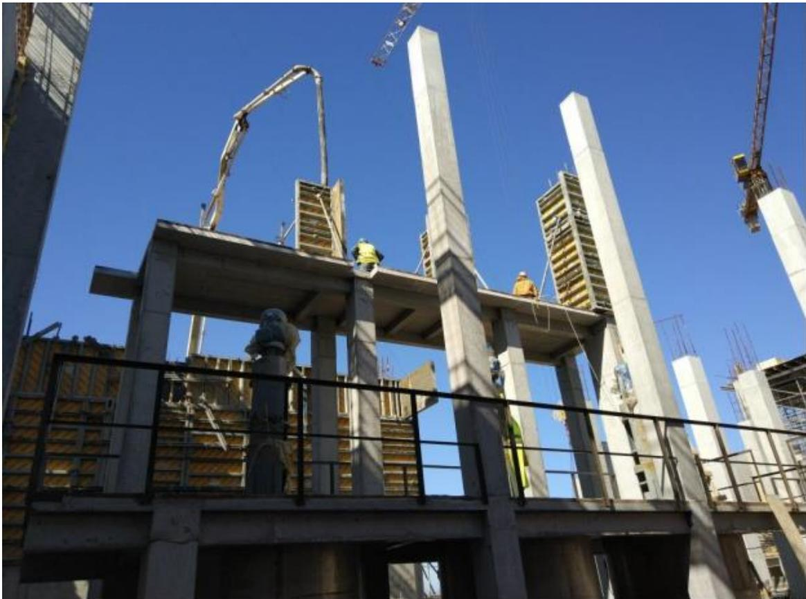
Рисунок 12 - Бетонирование колонн, подача бетонной смеси бетононасосом.
