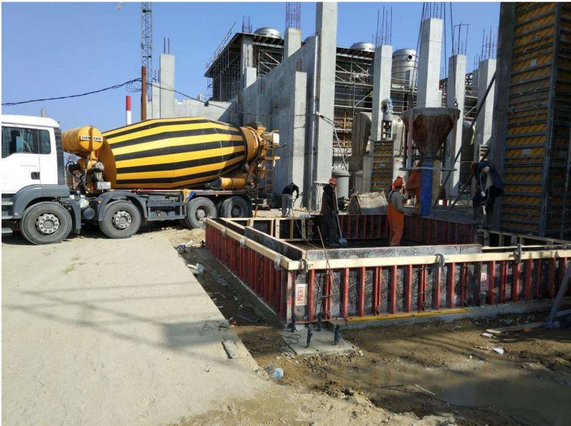
Рисунок 8 - Бетоновоз и подача бетона бадьёй.
