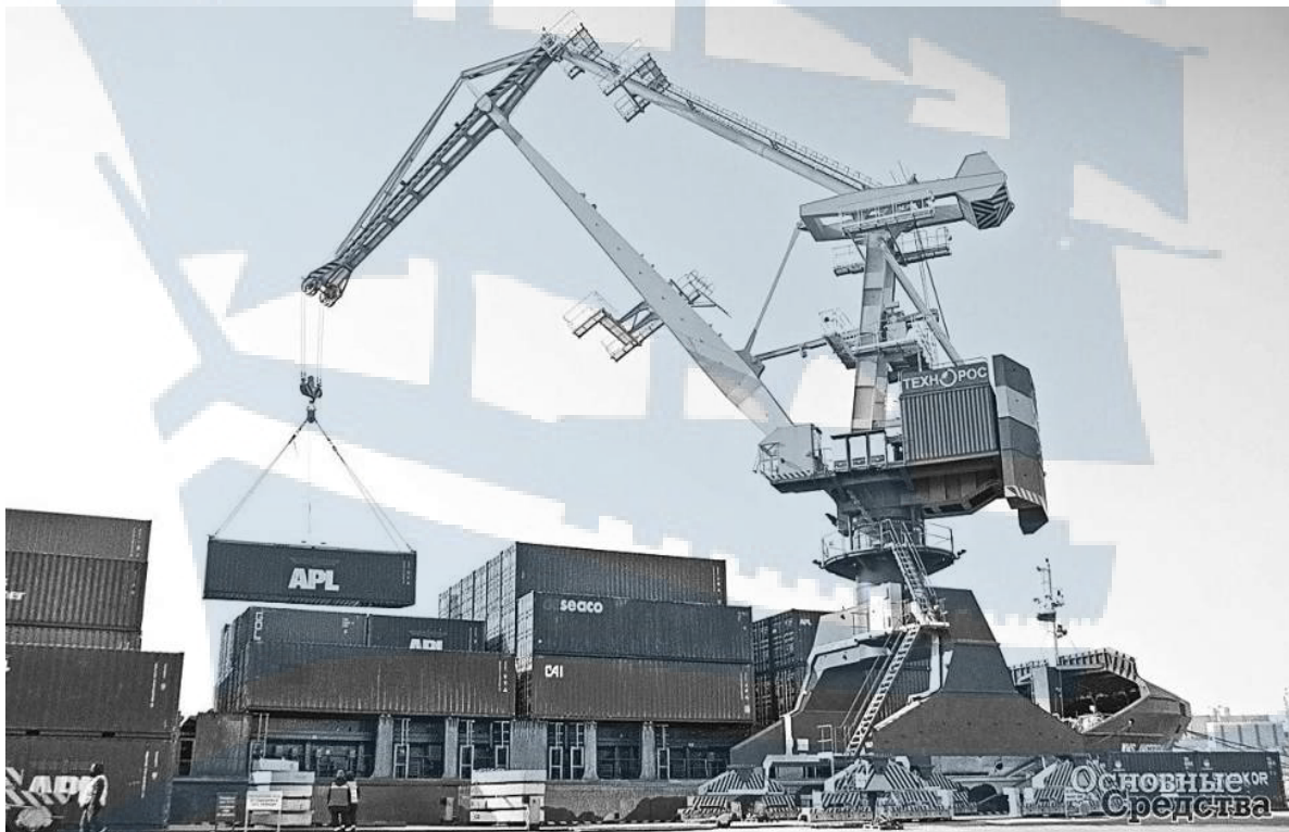
Рис. 95. Портальный кран для перегрузки контейнеров
