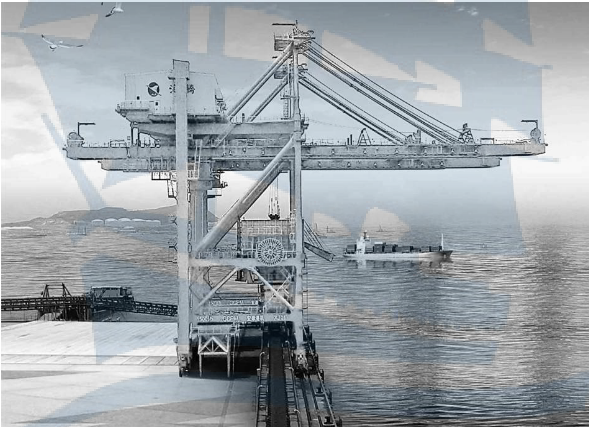
Рис. 91. Причальный контейнерный перегружатель
