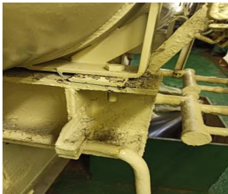
Рисунок 66. Фотография крепежа конденсатора.
