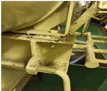
Рисунок 66. Фотография крепежа конденсатора.
