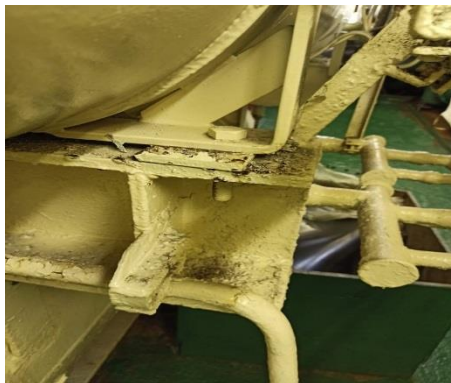
Рисунок 66. Фотография крепежа конденсатора.
