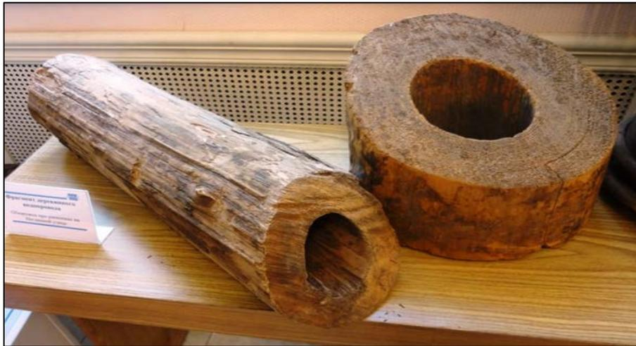
Рисунок 4 – Деревянный трубопровод (Музей ГП «Водоканал»)
