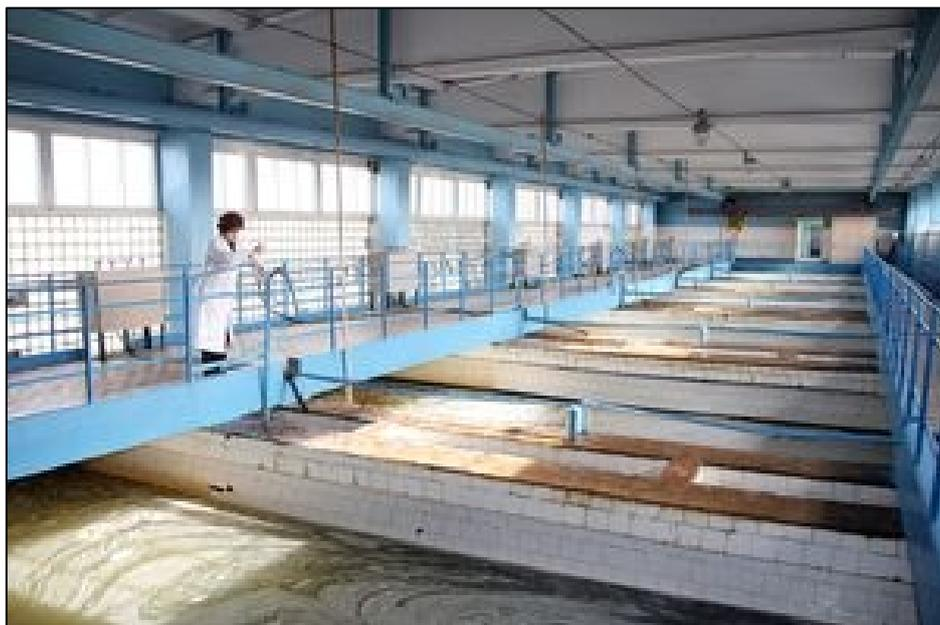
Рисунок 3 – Фильтрационный блок Южной водопроводной станции № 2
