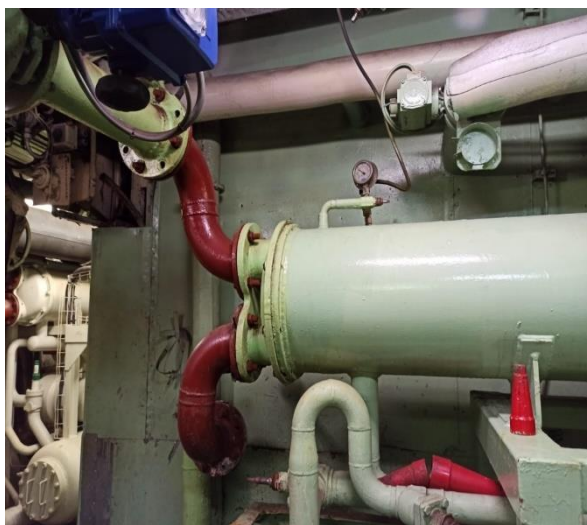
Рисунок 63. Фотография обработанных прилегающих трубопроводов.
