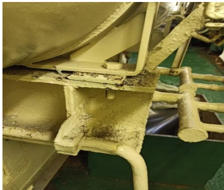
Рисунок 66. Фотография крепежа конденсатора.
